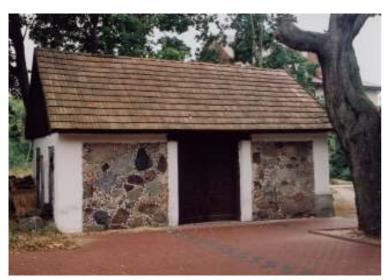
W bardzo bliskim sąsiedztwie kościoła zbudowano kostnicę. Ta niepodpiwniczona na planie prostokąta budowla z końca XIX w., wymurowana została z kamieni polnych tzw. otoczaków połączonych zaprawą wapienną. Naroża opaski otworów okiennych i oraz drzwiowych, rodzai tworzace lizen. połączono w jedną całość z biegnącym pod
