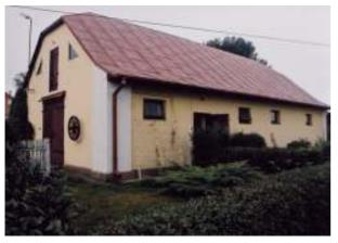
Tę niepodpiwniczoną parterową bryłę wzniesiono z cegły na zaprawie wapiennej. Naroża ujęto lizenami, a całość budynku rozczłonkowana została otworami okiennymi i drzwiowymi. Stajnię wieńczy dach naczółkowy z więźbą drewnianą krokwiowo-jętkową. Za stajnią, pod koniec XIX w. Włodzimierz Ludagowski zbudował stróżówkę. Bryłę, tej
