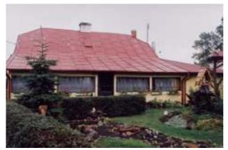
bez wyraźnych cech stylowych konstrukcji, wzniesiono na planie prostokąta, z werandą od frontu na całej elewacji budynku. Całość ujęto prostym gzymsem i lizenowymi narożami, wieńcząc go dachem naczółkowym z drewnianą więźbą krokwiowo-stolcową.
