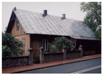
Kolejnym zabytkiem jest **organistówka** zbudowana w początku XX w. Ten drewniany parterowy budynek rzutowany został na planie prostokąta. Wzniesiono go na podmurówce kamiennej i podwalinie dębowej łączonej na nakładkę z zamkiem. Zrąb wzniesiono z bali sosnowych wysokości 280 cm, pionowo szalowanych, rozczłonkowanych prostokątnymi
